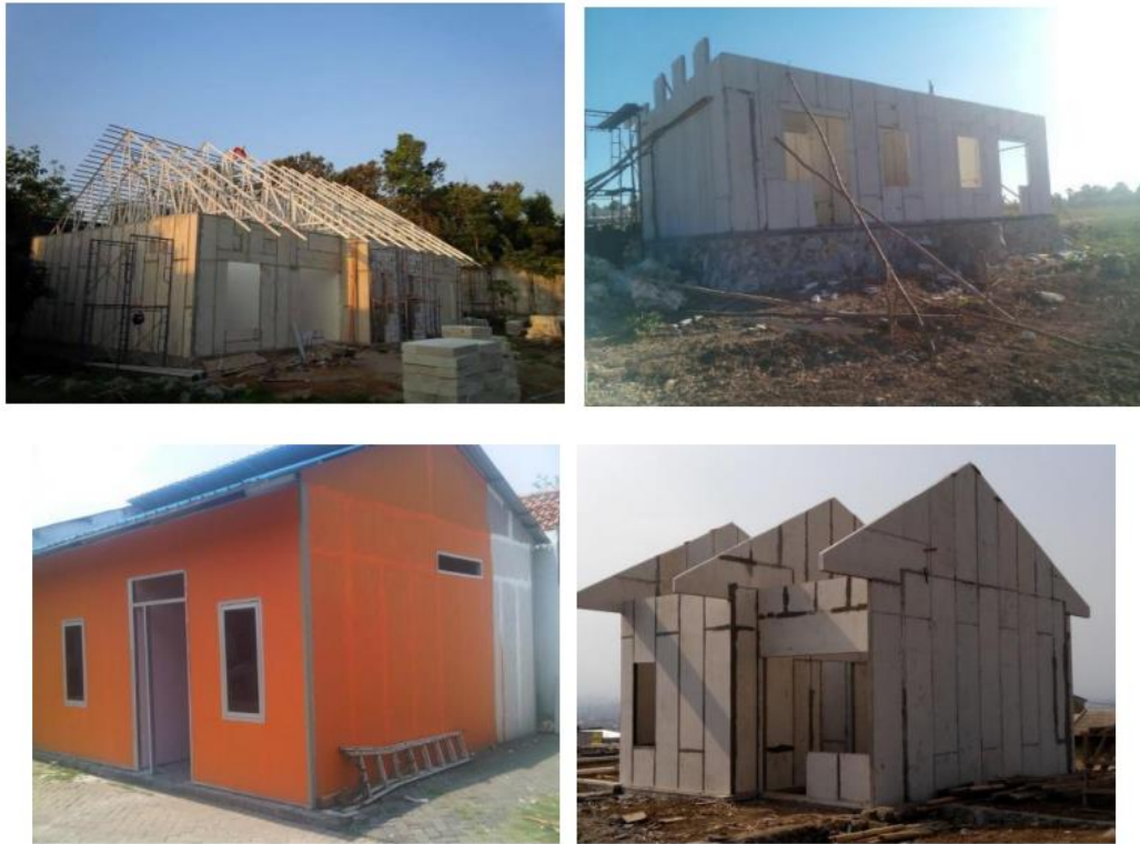
Gambar 3. 1 Rumah Menggunakan Dinding Panel Wallplus
