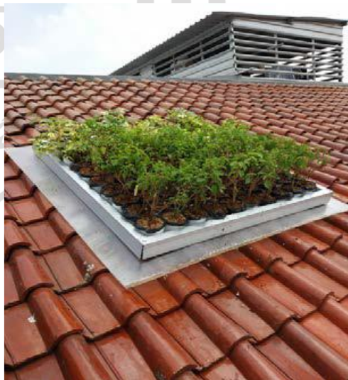
Gambar 3.5 Aplikasi Atap Hijau di Atap Miring
