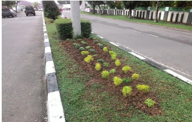
Gambar 3.8 Taman Hujan Jalan (Sumber: terkini.com)
