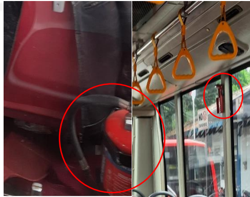
Gambar 5. 22 Alat Pemadam Api Ringan dan Alat Pemecah Kaca (sumber : Dokumentasi Pribadi, 2022)
