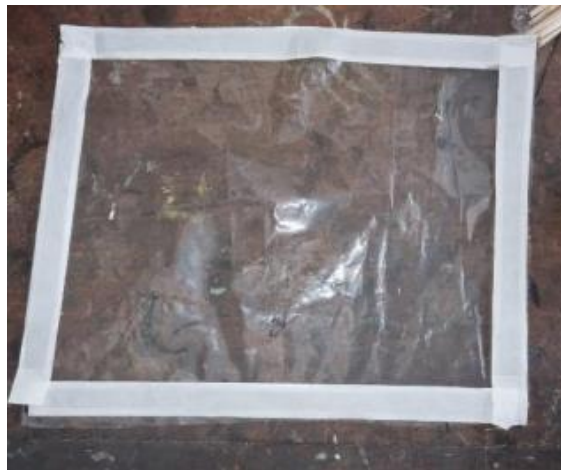
Gambar 3- 29 Pemasangan Sealent Tape
