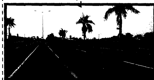
Ring Road Selatan, sebagai akses utama
