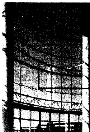
Penggunaan glass curtain wall sebagai elemen tembus pandang dan penggunaan struktur baja yang diekspose.
