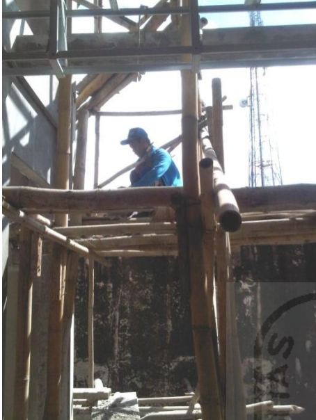
Gambar 5.6 Penggunaan perancah bambu yang aman (foto 10)
