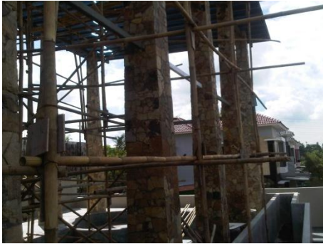
Gambar 5.8 Penggunaan perancah bambu yang aman (foto 12)
