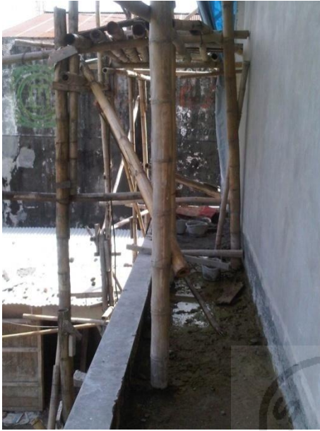
Gambar 5.4 Penggunaan perancah bambu yang aman (foto 7)
