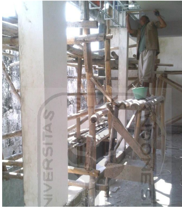
Gambar. 3.1 Perancah Kerja Panggung Dari Bambu
