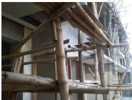
Gambar 5.14 Penggunaan perancah bambu yang tidak aman (foto 4)
