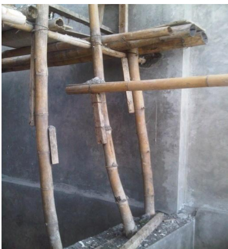
Gambar 5.3 Penggunaan perancah bambu yang aman (foto 3)
