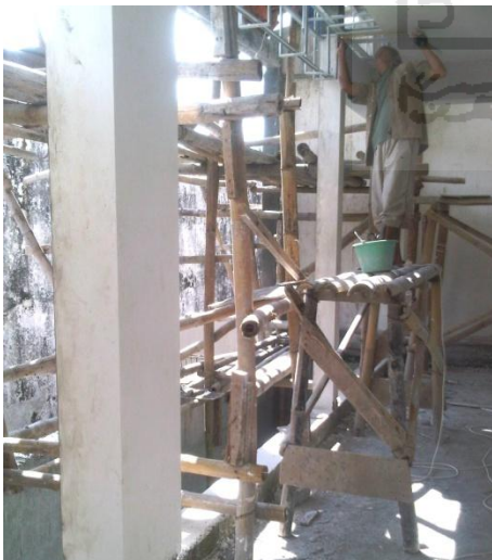
Gambar 5.7 Penggunaan perancah bambu yang aman (foto 11)
