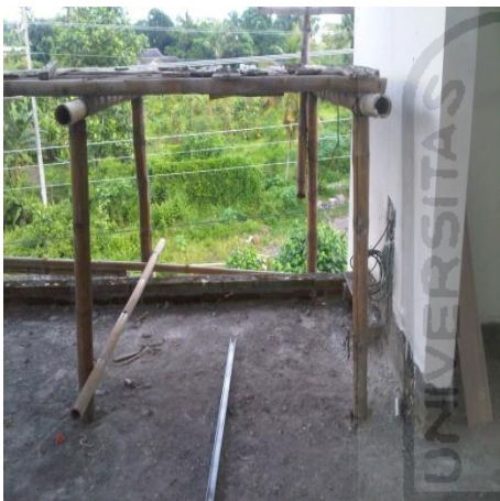
Gambar 5.9 Penggunaan perancah bambu yang aman (foto 15)
