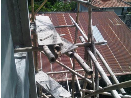
Gambar 5.13 Penggunaan perancah bambu yang tidak aman (foto 2)
