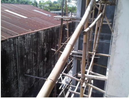
Gambar 5.16 penggunaan perancah bambu yang tidak aman (foto 6)
