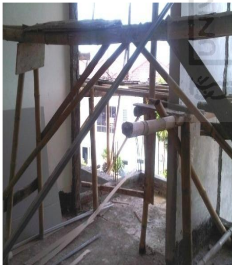
Gambar 5.5 Penggunaan perancah bambu yang aman (foto 9)
