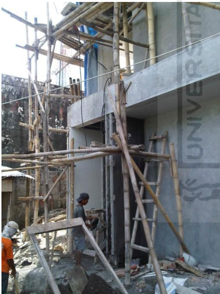
Gambar 5.12 Penggunaan perancah bambu yang aman (foto 20)
