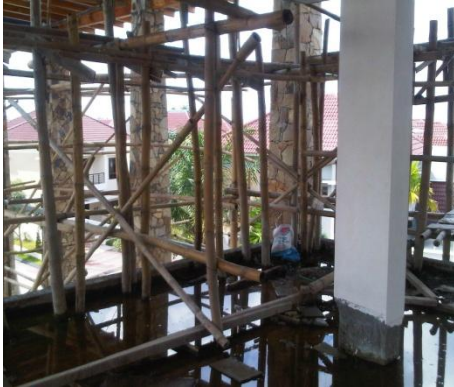
Gambar 5.11 Penggunaan perancah bambu yang aman (foto 18)
