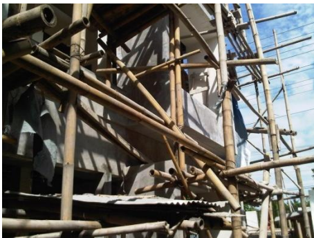
Gambar 5.15 Penggunaan perancah bambu yang tidak aman (foto 5)
