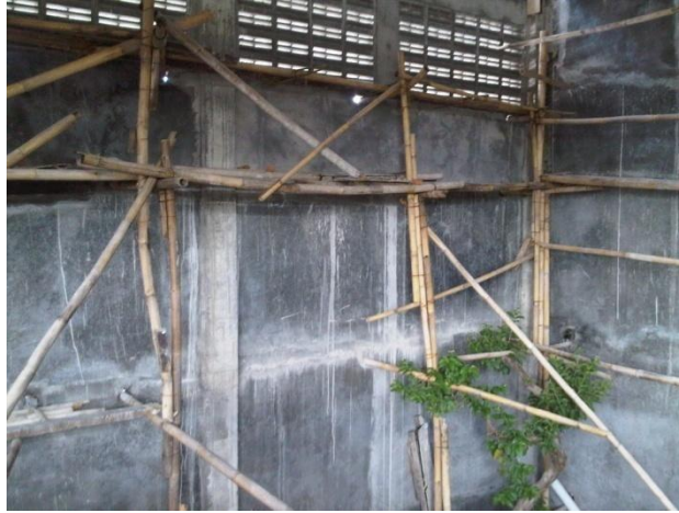
Gambar. 3.2 Perancah Pengaman Dari Bambu
