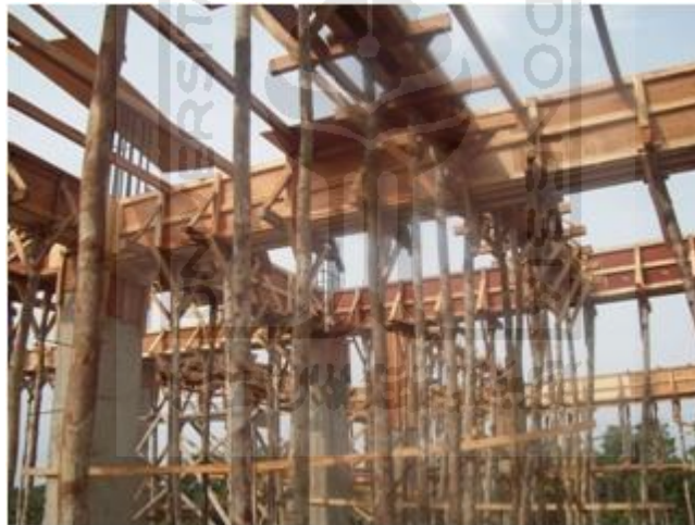
Gambar 3.3 Perancah Penyangga Tegak Dari Kayu
