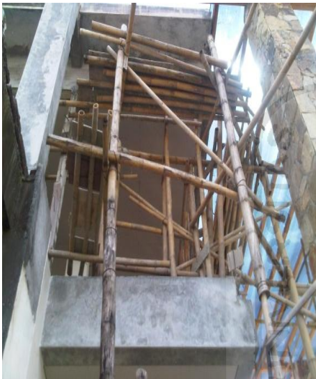
Gambar 5.3 Penggunaan perancah bambu yang aman (foto 3)
