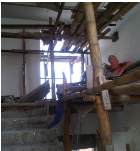
Gambar 5.10 Penggunaan perancah bambu yang aman (foto 17)
