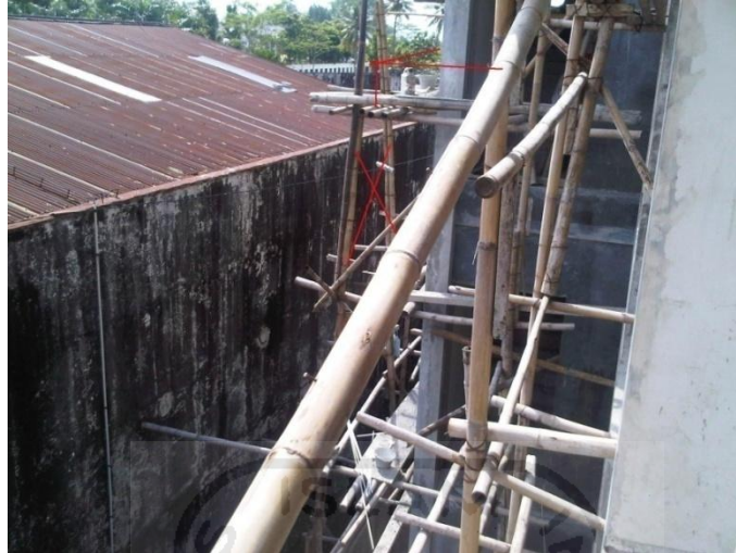
Gambar 5.1 Perancah bambu tanpa pagar pengaman dan pangaku cross
