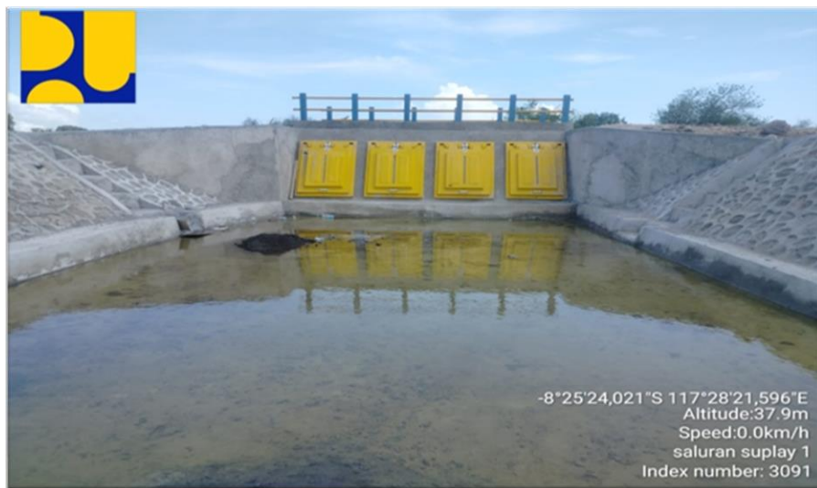
Gambar 3.2 Jembatan dan Pintu Klep Sebagai Kegiatan Jaringan Irigasi
