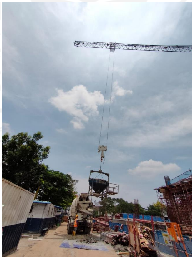
Gambar L-1.6 Pengangkatan Bucket Cor
