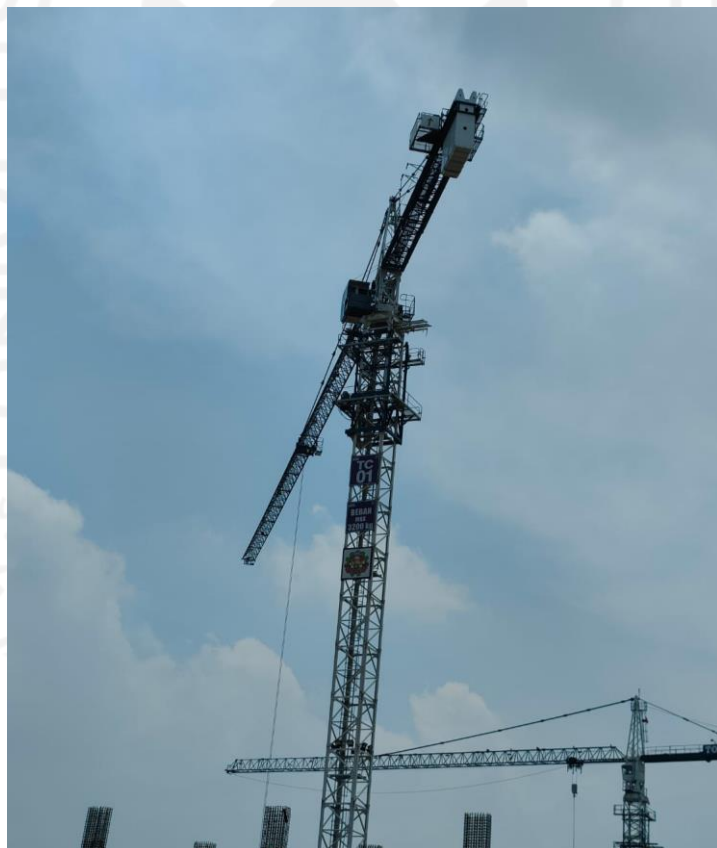
Gambar L-1.2 Tower Crane 01 Beban 3200 kg
