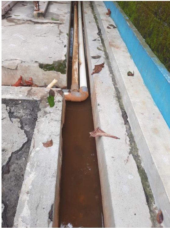
Kekeruhan Air Dari Filter Tank yang sedang dibersihkan
