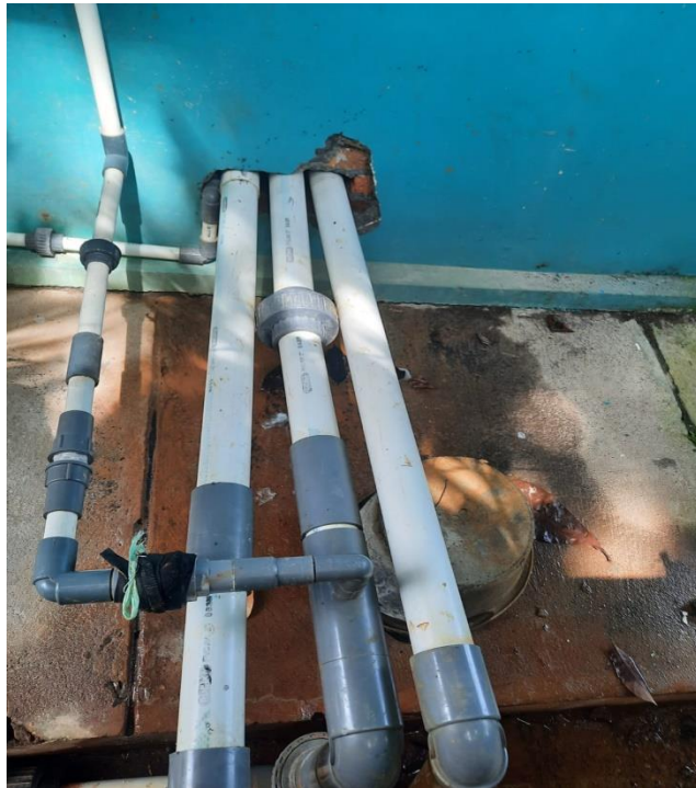
Gambar 4. 9 Pipa Jaringan Distribusi Utama dan Pipa Pengurasan Air Filter Tank
