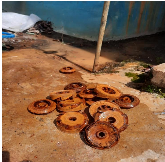
Gear Pompa Terkontaminasi Kadar Besi sumber air baku
