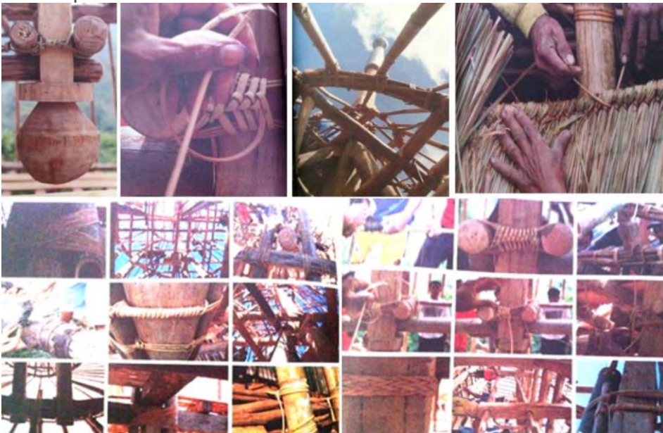
Gambar 2.25 Teknik Ikatan Rotan Sumber : Antar, 2013
