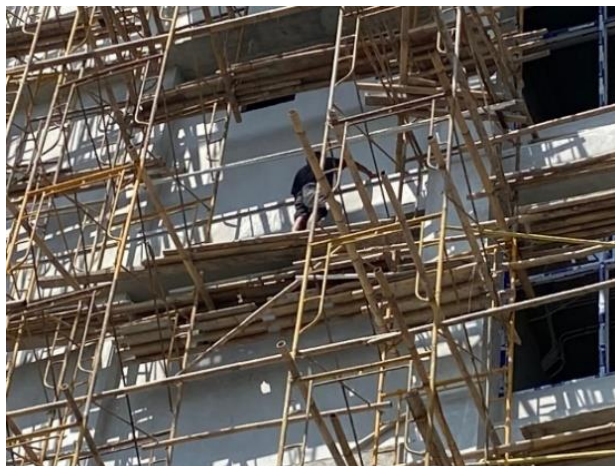
Gambar 3. 5 Proses pekerjaan Plesteran Dinding Luar
