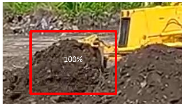
Gambar 5.21 Blade Bulldozer Terisi Penuh Material
