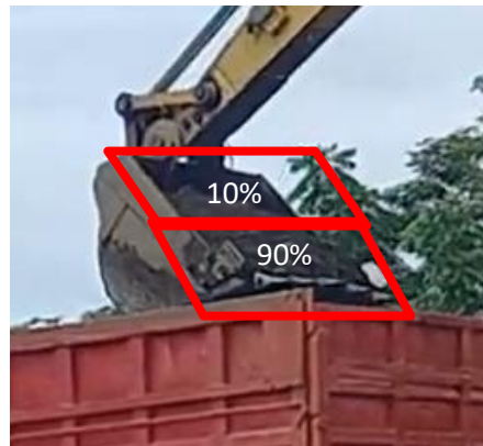
Gambar 5.20 Bucket Excavator Tidak Terisi Penuh Material
