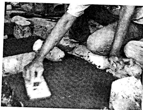
Gambar 11. Penuangan Sampel pada Bekisting
