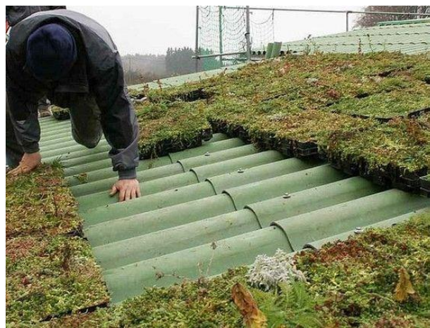
Gambar 3.3 Pemasangan Tumbuhan Pada Atap Hijau (Sumber: Livios.be, 2014)
