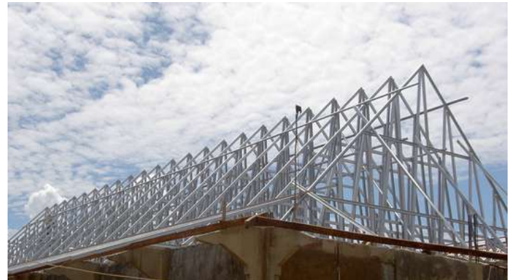
Gambar 3.24 Rangka Atap Baja Ringan Sumber: bajaringanvivo.co..id
