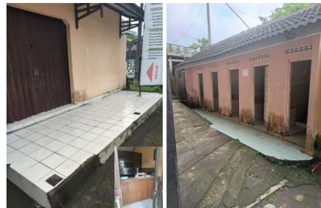
Gambar 1.15 Ruang UPJ (Kiri) dan WC/Toilet (Kanan) Sumber: penulis, 2024
