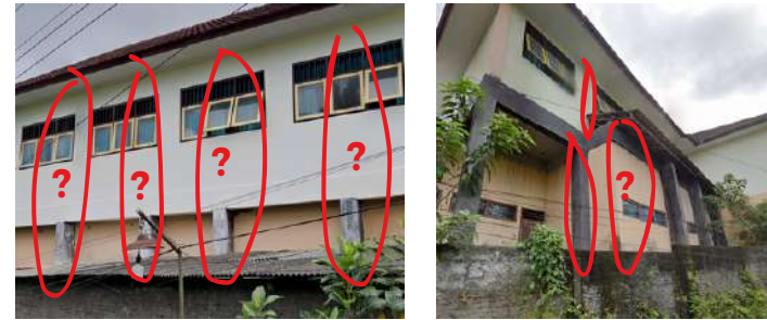
Gambar 1.7 Struktur Kolom tidak menerus Sumber: google maps
