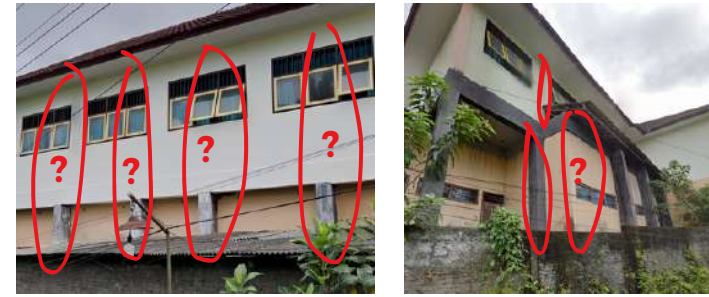
Gambar 1.7 Struktur Kolom tidak menerus Sumber: google maps
