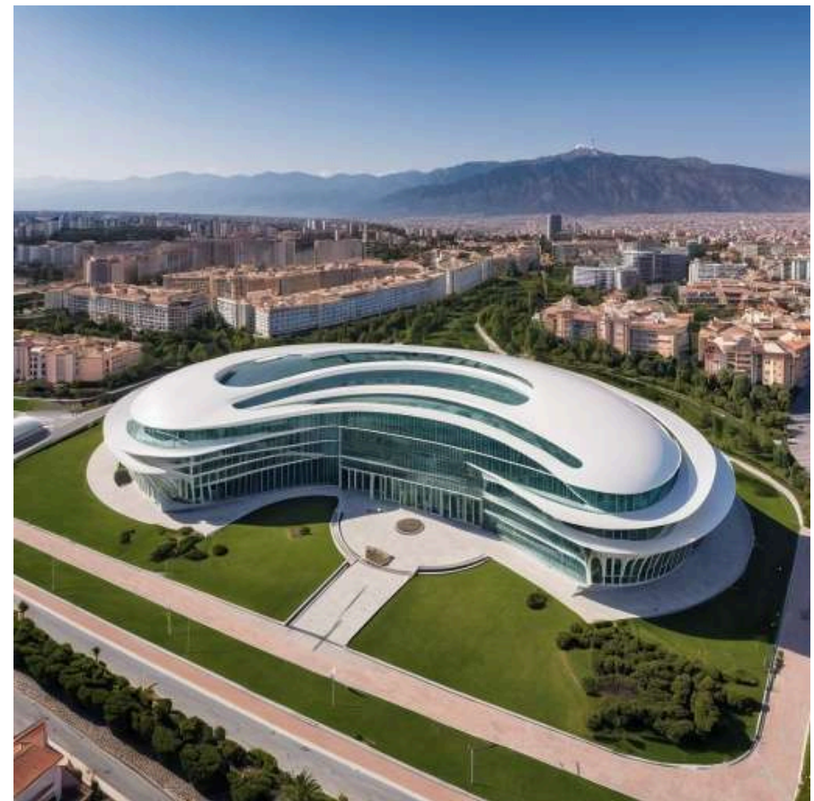
Gambar x Bangunan Rehabilitasi Sumber : promeai.pro
