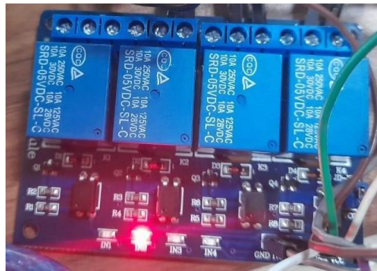
Gambar 5.14 Kondisi ketika relay bekerja dengan baik
