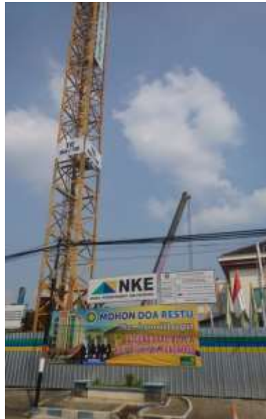
Gambar 1.1 Proyek Pembangunan Rumah Sakit Umum Aisyiyah Ponorogo
