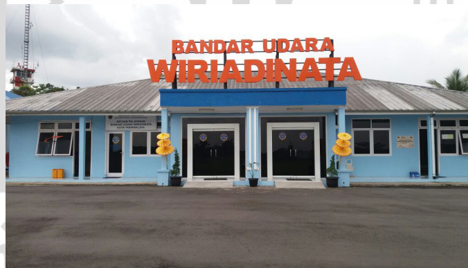
Gambar 1.1 Terminal Bandar Udara Wiriadinata sumber : penulis
