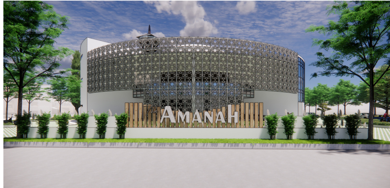
Tampak Fasad Bangunan dari Arah barat
