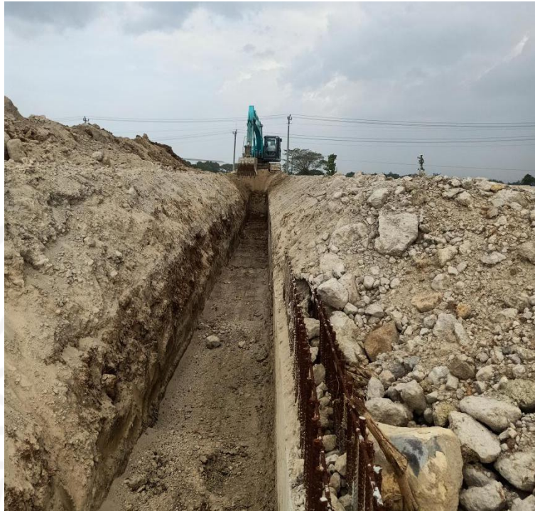
Gambar L-7.1 Pekerjaan Galian Pada Lokasi Proyek
