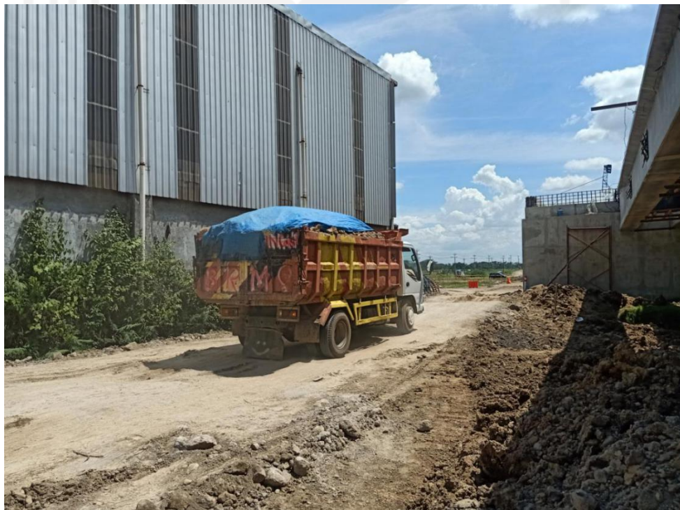
Gambar L-7.2 Pekerjaan Angkut Material
