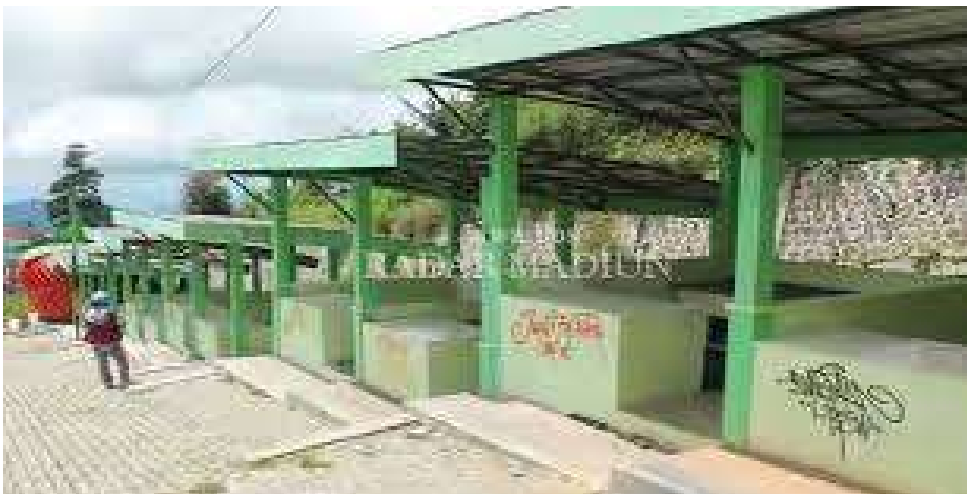
Gambar 1.2.2 Infrastruktur Terbengkalai Sumber: Jawa Pos Radar Madiun, 2019
