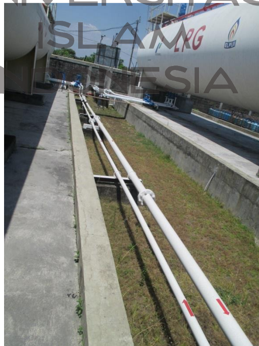
Gambar 5.11 Pipa liquid dan vapor area penimbunan
