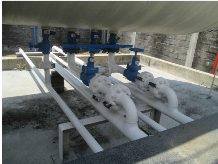
Gambar 5.12 Valve vapor dan liquid
