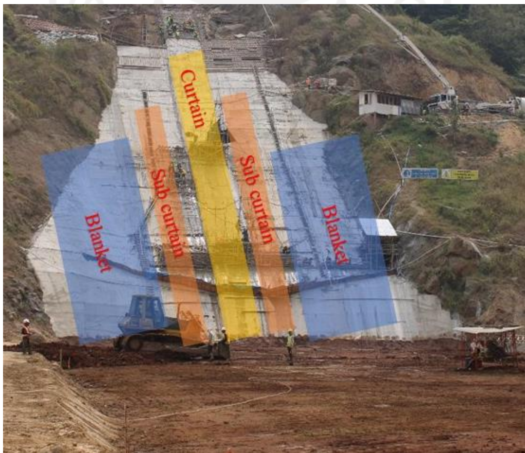
Gambar 5.1 Lokasi Grouting Sandaran Kiri
