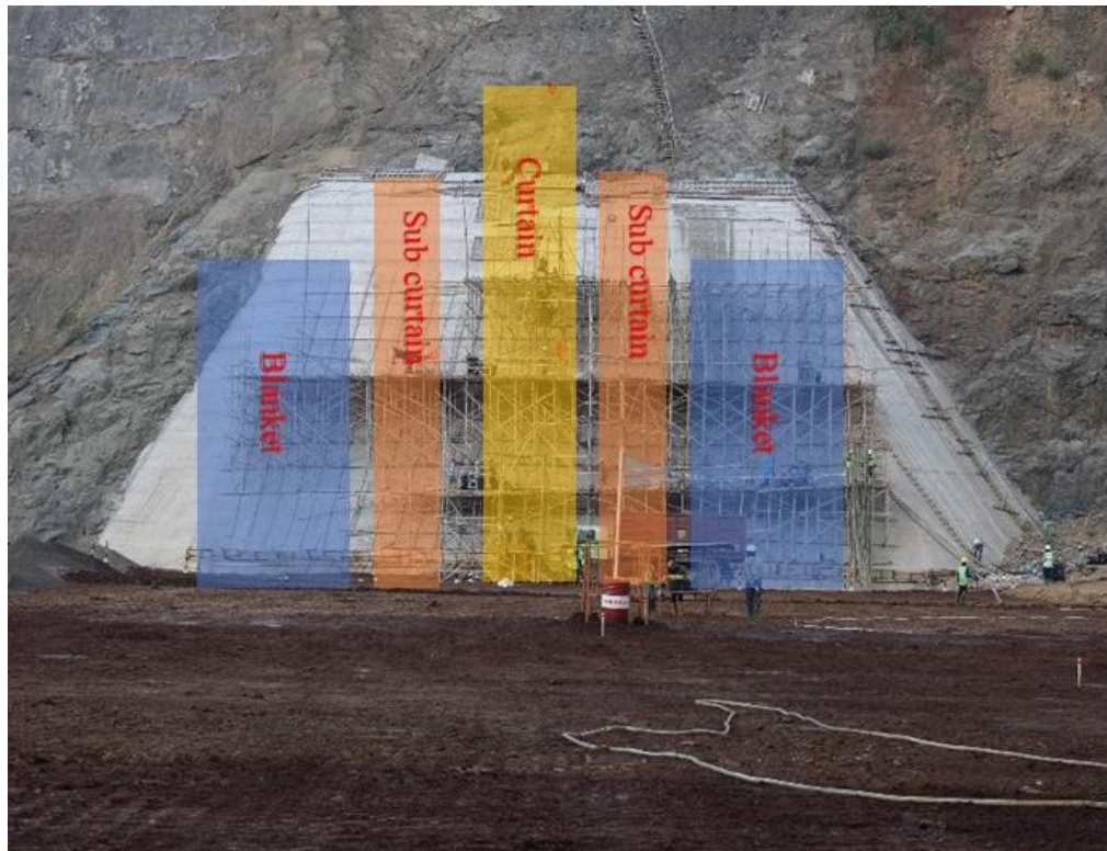
Gambar 5.2 Lokasi Grouting Sandaran Kanan
