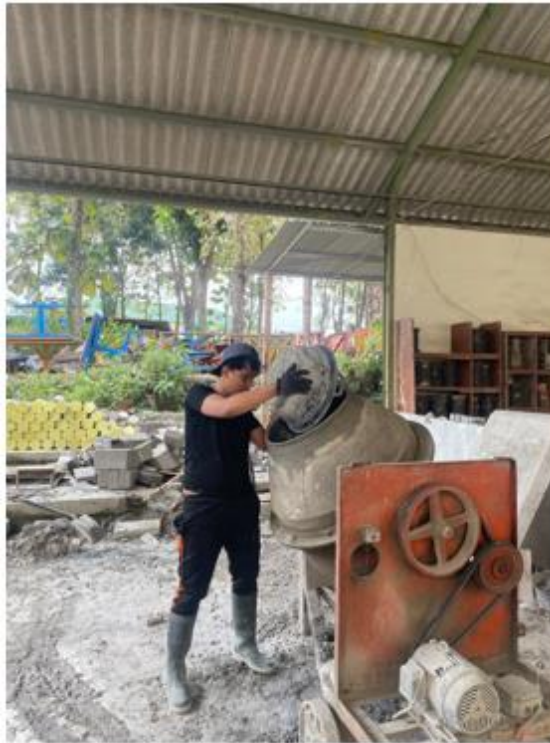
Gambar L-8.1 Pembuatan Beton Segar
