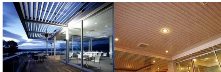
Gambar 3.25. Sun Louvre dan Plafond Akustik
