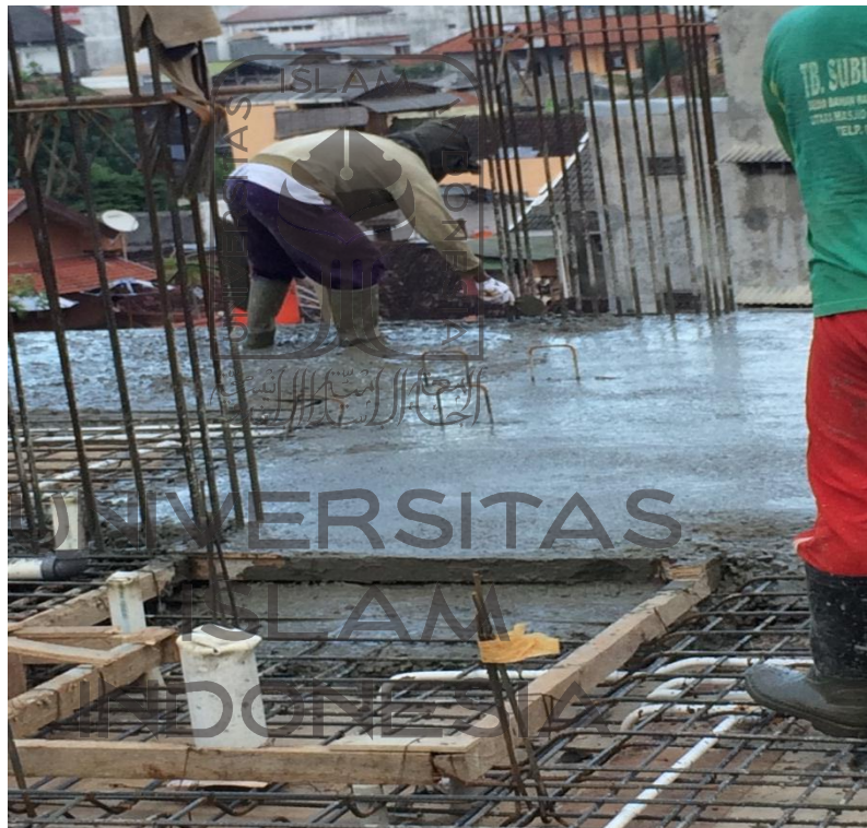
Gambar 3.1 Pelat Lantai Beton.
