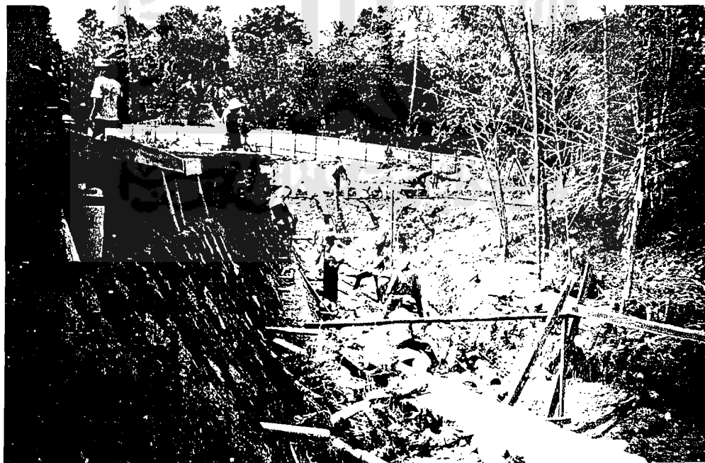
Gambar 5.3 Foto Pekerjaan talud
