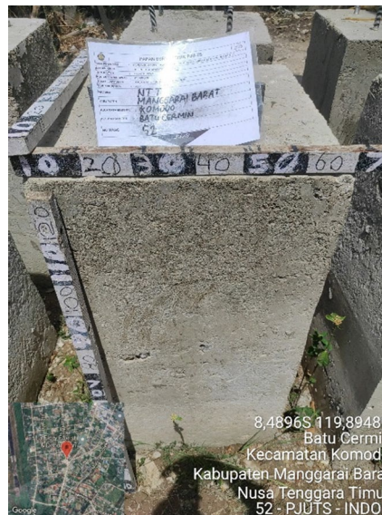
Gambar 4.9 Foto Precast pondasi
