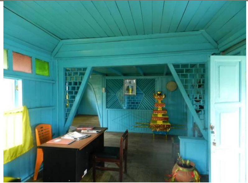
Gambar Struktur Kolom Miring pada Rumah Tradisional Melayu
