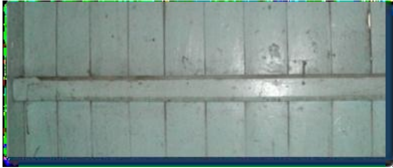
Gambar Dinding Kayu vertikal yang di Perkuat dengan Kayu Balok Horizontal
