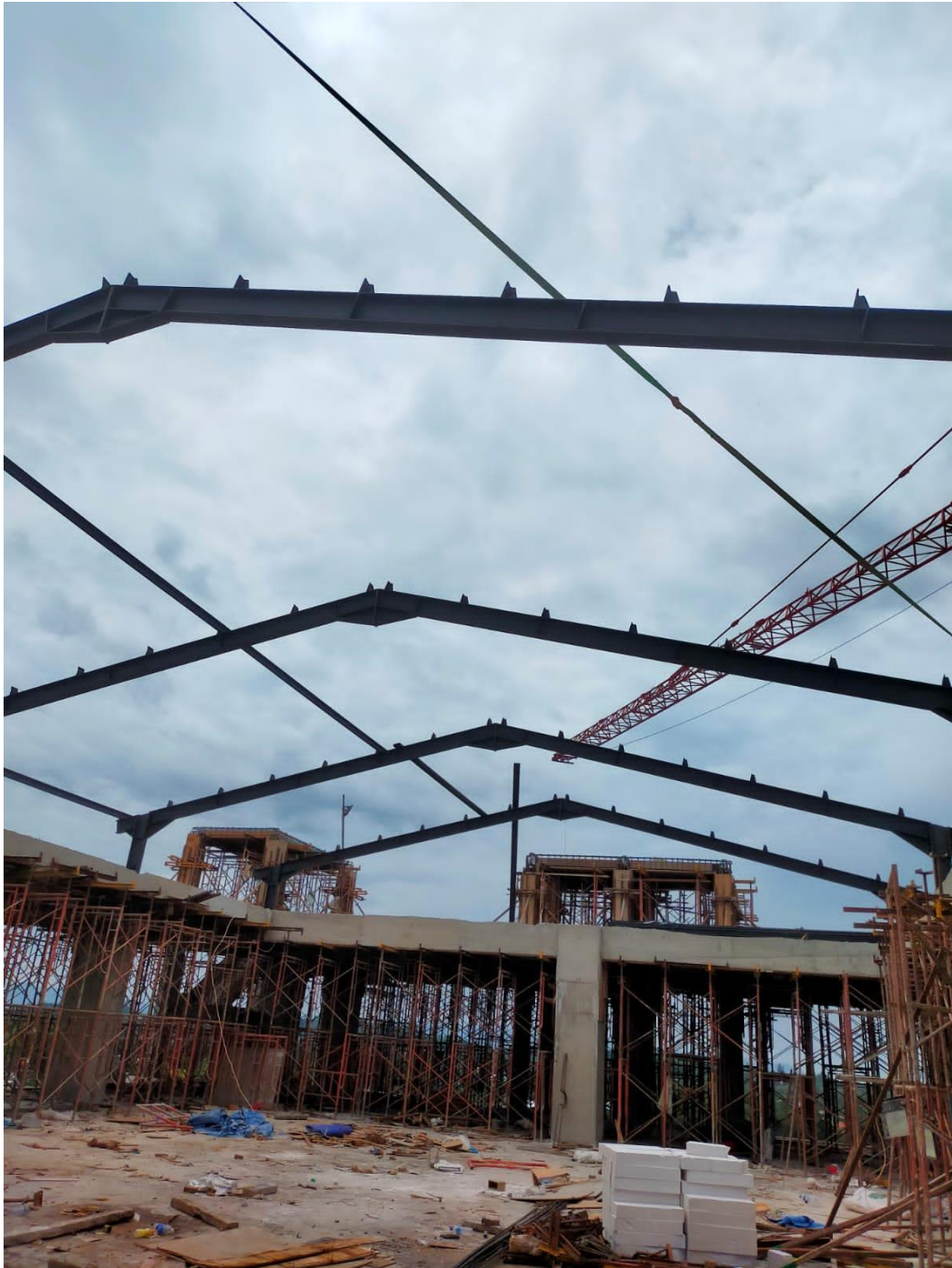
Gambar L-3.2 Proses Pemasangan Kuda-Kuda dan Gording
