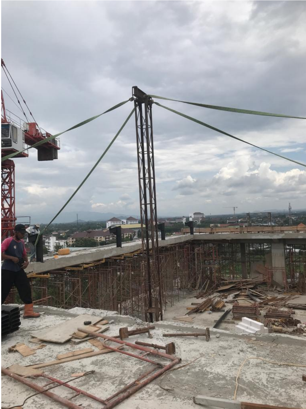
Gambar L-3.1 Proses Pendirian Alat Bantu Katrol
