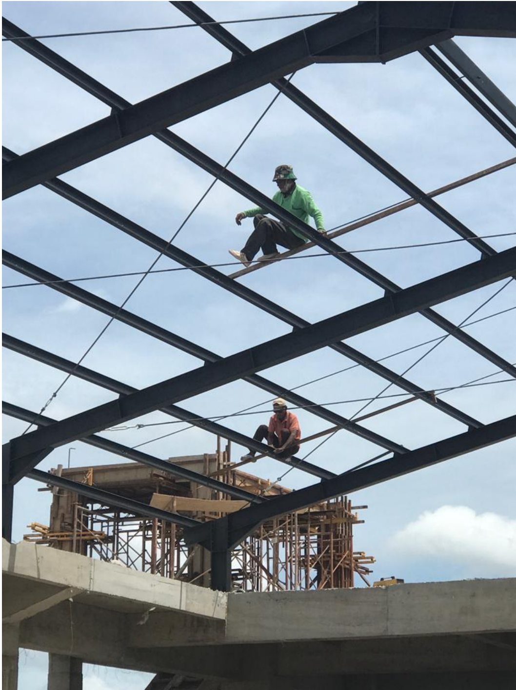
Gambar L-3.5 Proses Pemasangan Sag Rod
