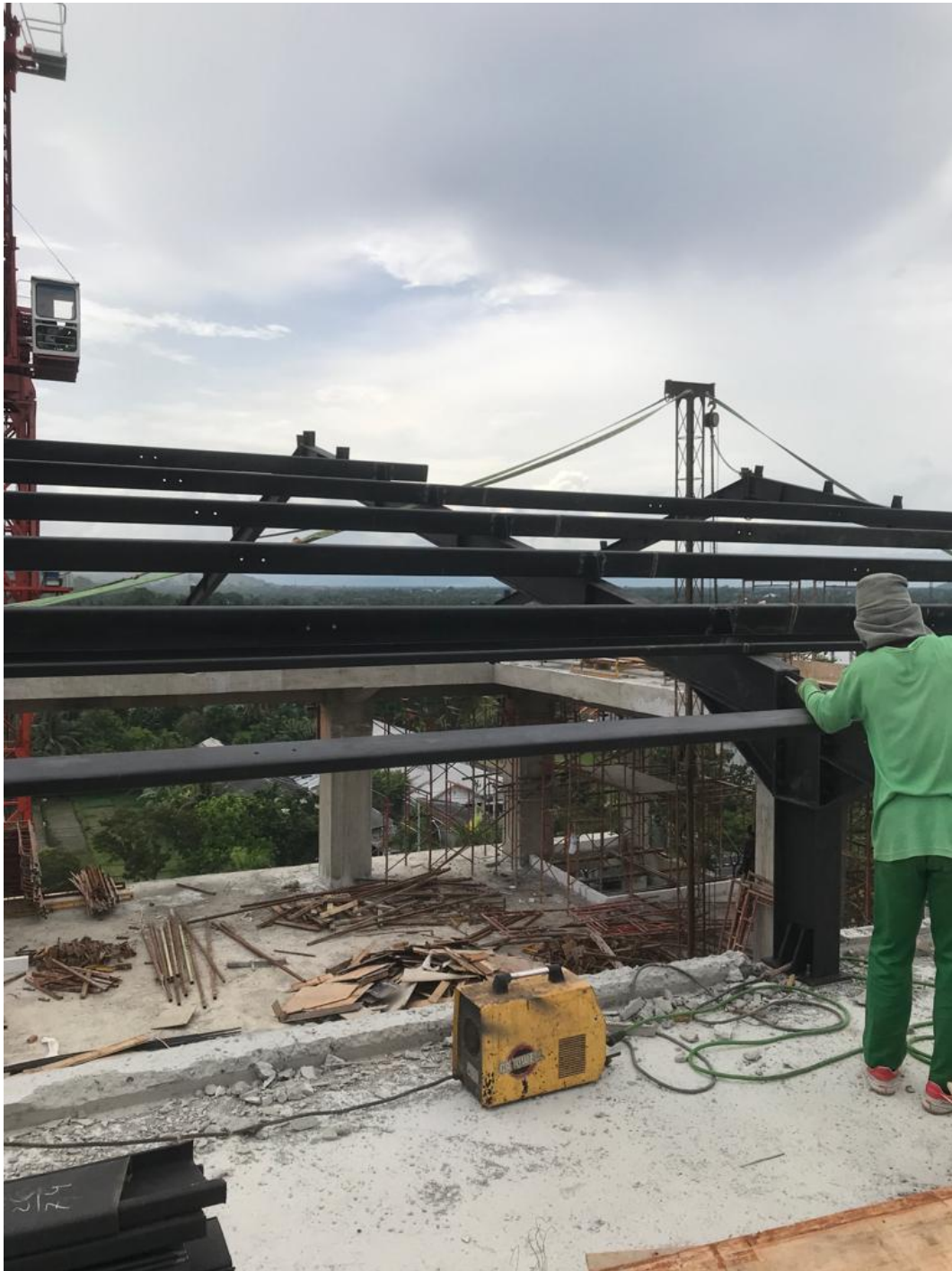
Gambar L-3.7 Proses Pengelasan Baja
