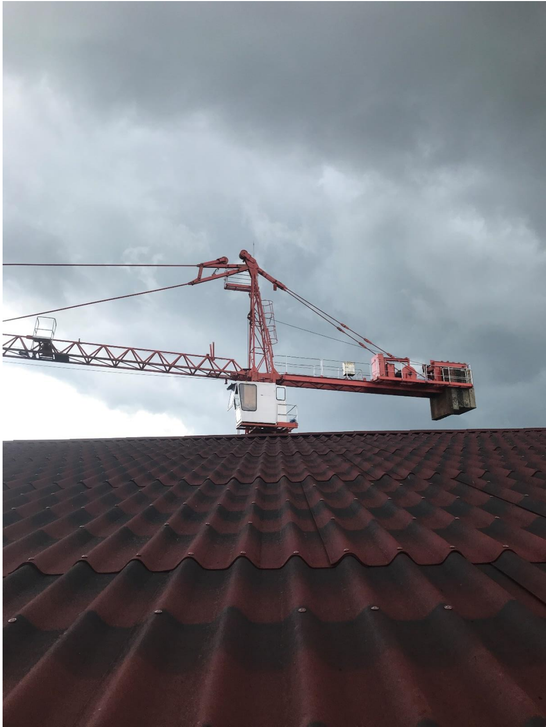
Gambar L-3.4 Proses Pemasangan Atap Onduline
