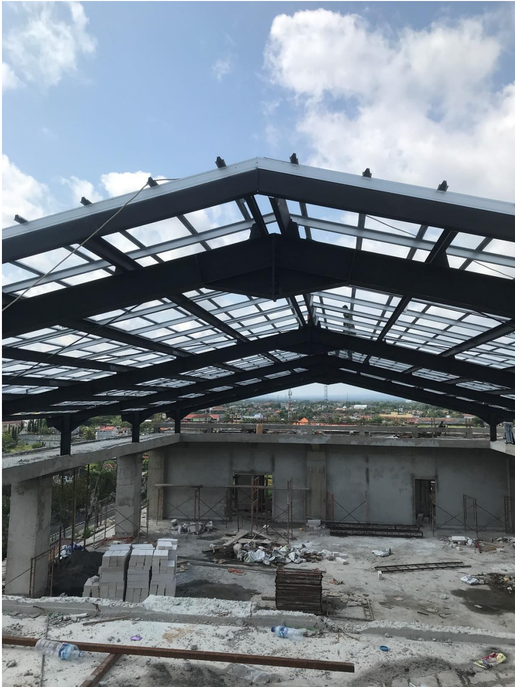
Gambar L-3.3 Proses Pemasangan Usuk dan Reng
