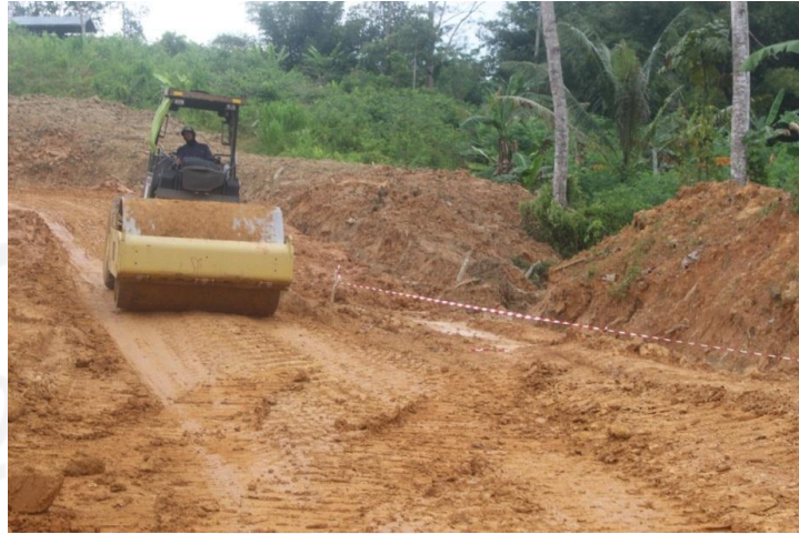
Gambar 1.1 Kondisi Tanah Pada STA 1+750 Sampai STA 2+150
