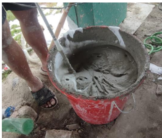
Gambar L 4. 8 Aduk Campuran Hingga Homogen
