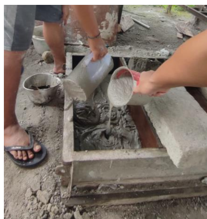
Gambar L 4. 9 Penuangan Campuran Bata Ringan Kedalam Cetakan
