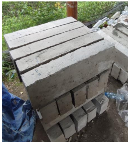
Gambar L 4. 11 Bata Ringan Diletakkan Ditempat Yang Disediakan
