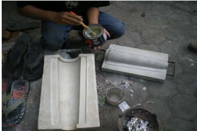
Gambar 3-9 Proses Pengolesan M.A.A Pada Cetakan.
