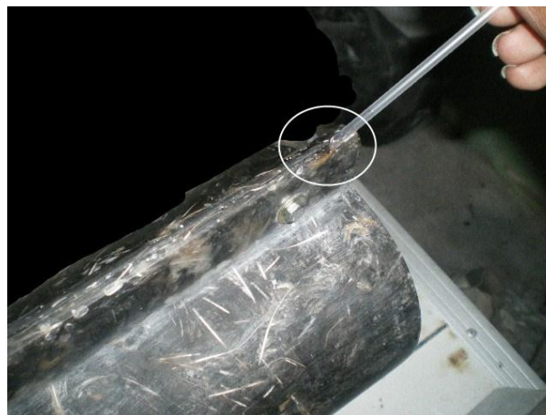
Gambar 4-10 Pengisian Campuran Resin dan Katalis Kedalam Rongga
