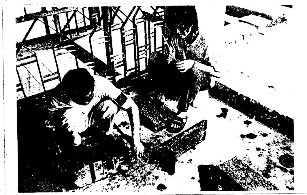
Gambar 5. Pembongkaran cetakan batako dan pemberian tanda.
