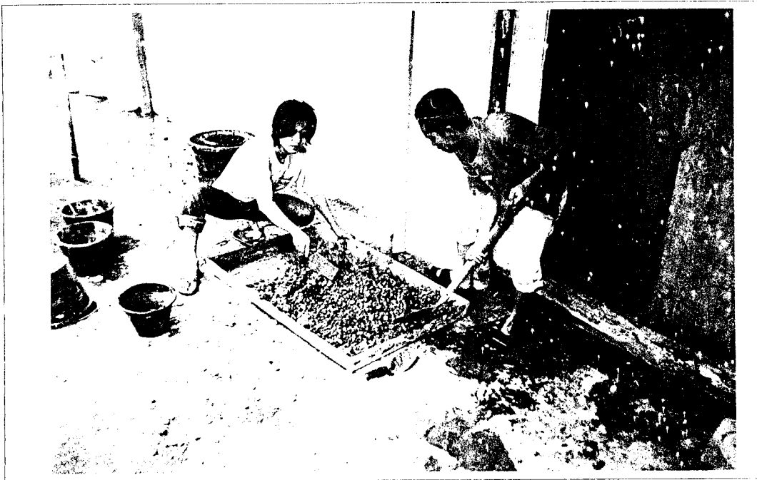
Gambar 3. Pengadukan campuran batako (semen, krikil, dan air)
