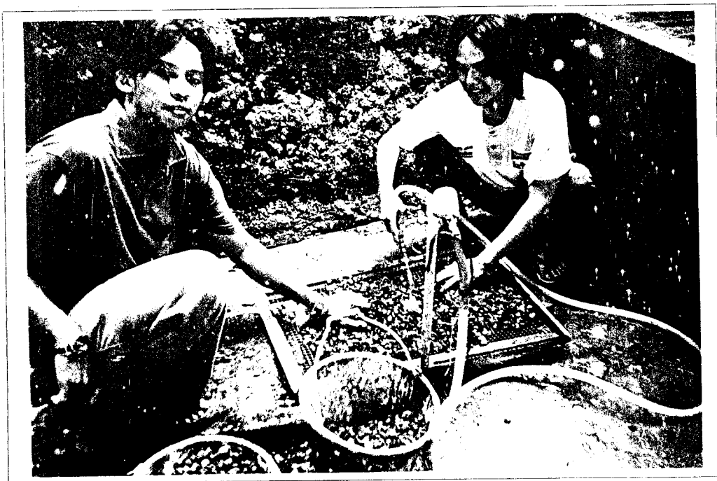
Gambar 2. Pencucian agregat untuk membuang Lumpur dan pasir yang melekat.
