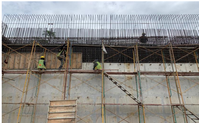
Gambar 5.2 Pekerjaan Abutment Jembatan
