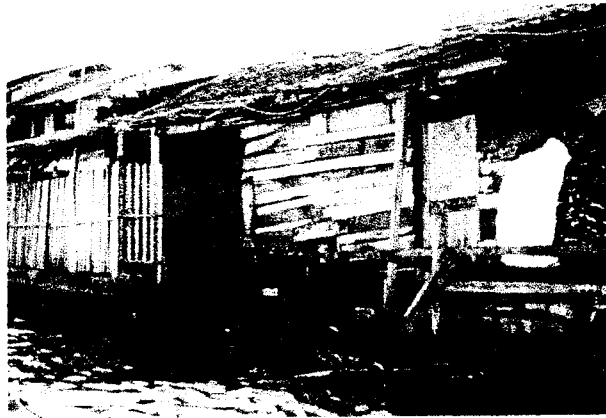
Gb. II. 13. Contoh bangunan rumah yang kondisinya cukup buruk
