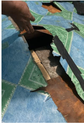
Gambar 4.10 Kondisi sumur pada SD 6
