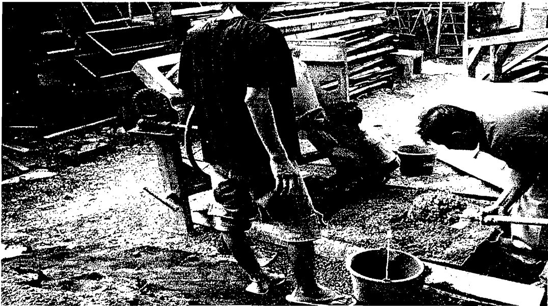
Pembuatan campuran adukan beton dengan molen
