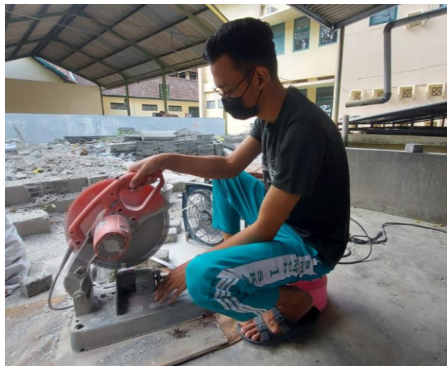
Gambar L-5.5 Proses Pemotongan Paving Block
