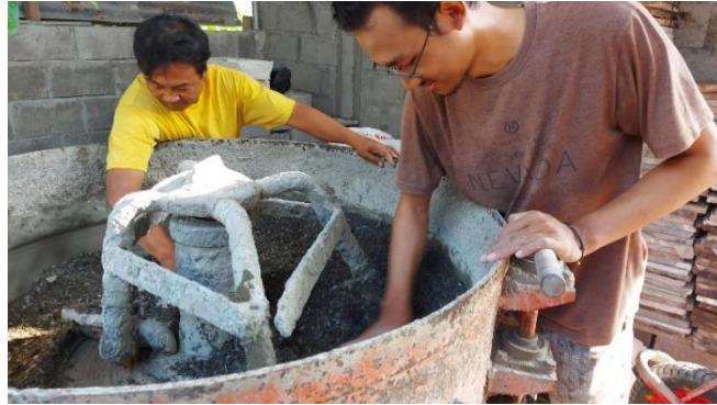
Gambar L-5.1 Proses Pencampuran Bahan Penyusun Paving Block
