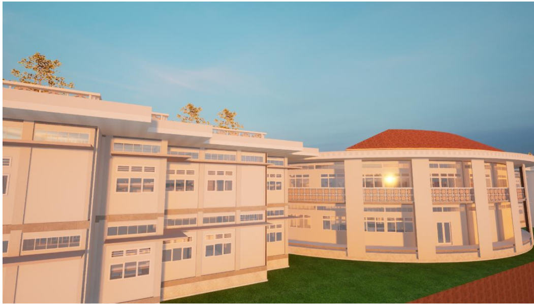
Gambar 5.28 Eksterior Bagian Belakang Bangunan Sekolah dan Asrama Putra
