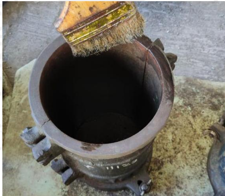
Gambar L-1.10 Pengolesan Oli pada Bekisting
