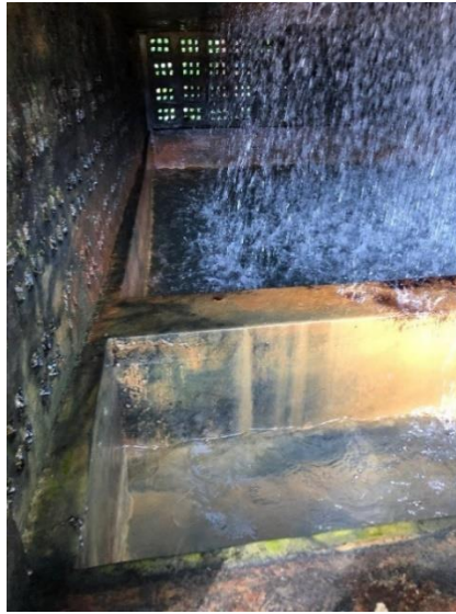
Gambar 3. 5 Pengambilan Sampel pada Unit Aerasi
