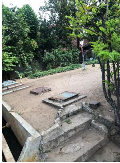
Gambar 3. 8 Pengambilan Sampel pada Unit Reservoir
