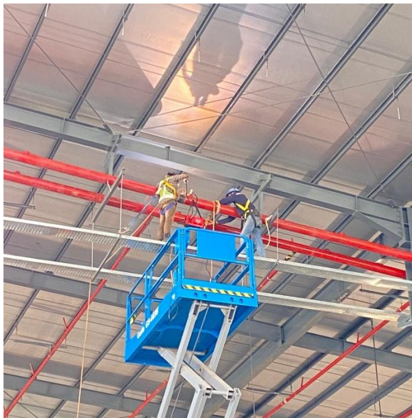
Gambar L-1.10 penyesuaian dan penyambungan antar pipa hydrant
