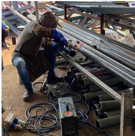
Gambar L-1.2 Fabrikasi Pipa Hydrant
