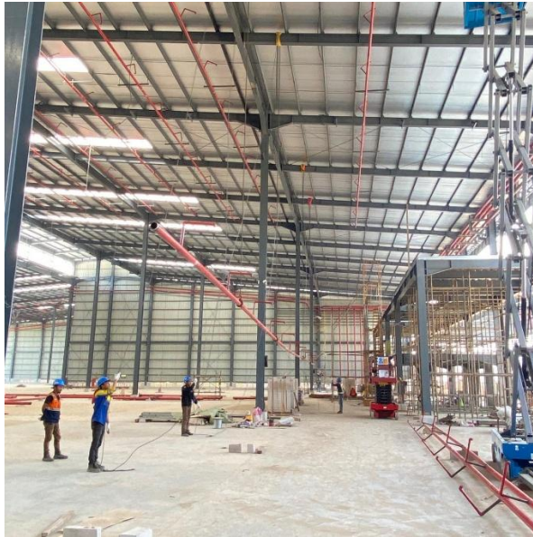
Gambar L-1.9 pengangkatan pipa hydrant
