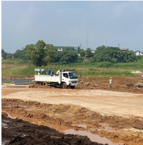
Gambar L-1.3 Pelangsiran Support dan Pipa Hydrant dari tempat fabrikasi ke lokasi lapangan proyek
