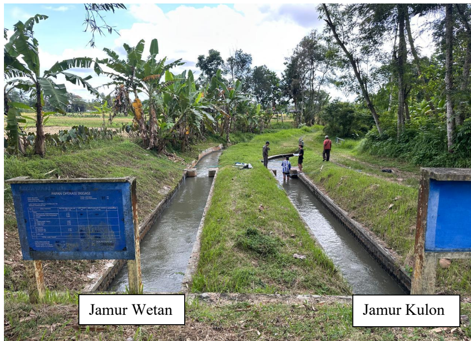
Gambar 4. 2 Kondisi Bangunan Ukur Ambang Lebar Jamur Wetan dan Jamur Kulon
