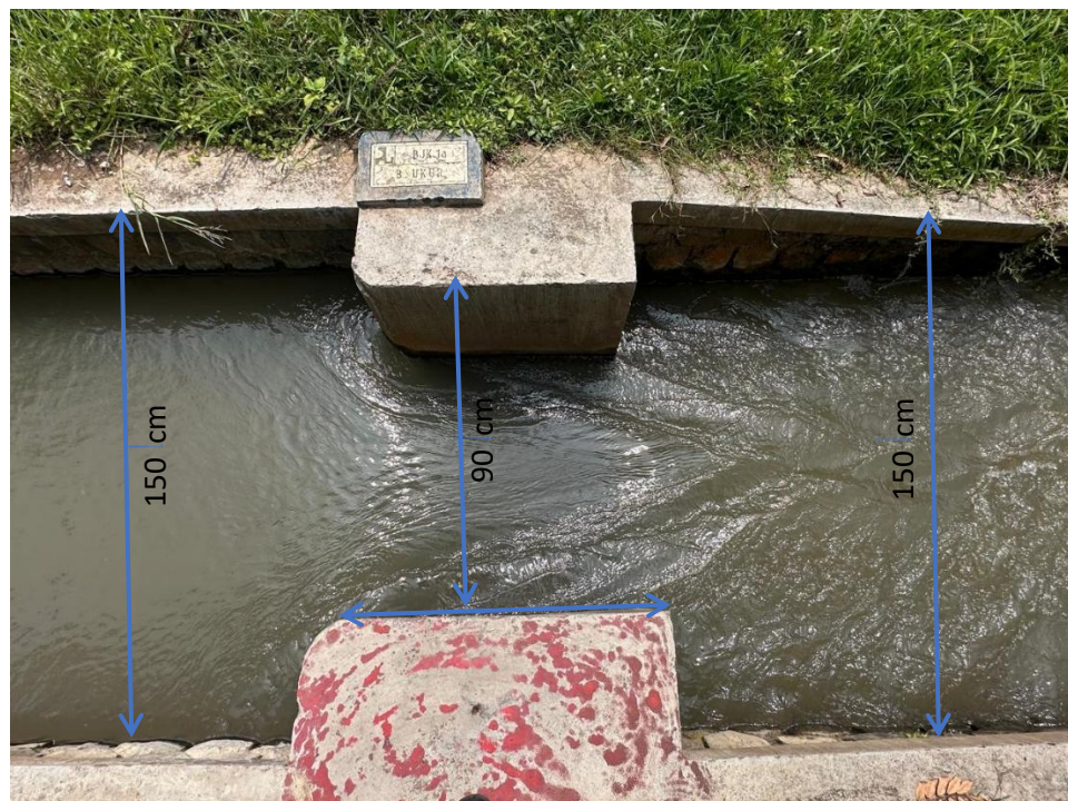
Gambar 4. 3 Dimensi Bangunan Ukur Ambang Jamur Kulon
