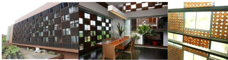
Gambar 2. Bangunan studi preseden yang menggunakan botol kaca sebagai elemen Double Skin Fasad yaitu ; Rumah Botol karya Ridwan Kamil.
