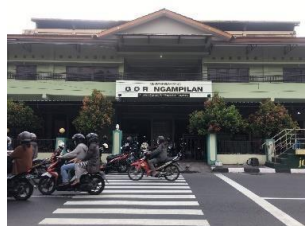
Gambar 4. Tampak bangunan eksisting GOR Ngampilan
