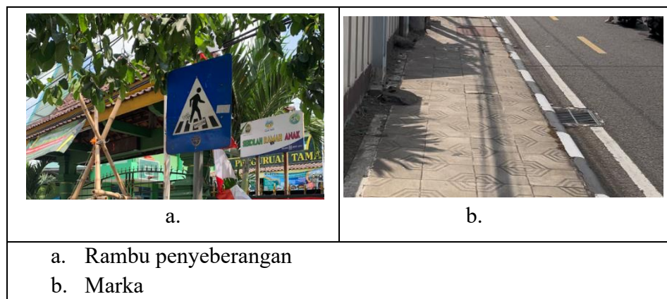
Gambar 5.21 Fasilitas Pendukung Pada Segmen 3
