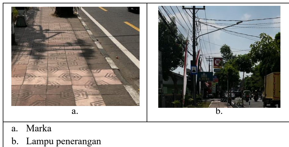
Gambar 5.29 Fasilitas Pendukung Pada Segmen 2
