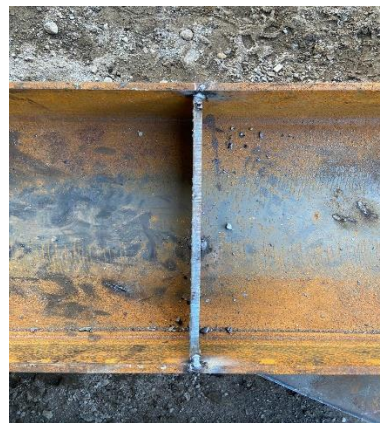
Gambar L-2.2 Plat Stiffner Balok
