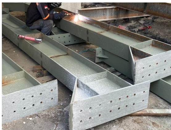
Gambar L-1.3 Balok WF 400 x 200 x 8 x 13
