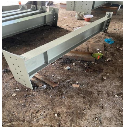
Gambar L-1.5 Balok WF 300 x 150 x 6,5 x 9
