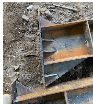
Gambar L-2.3 Plat Sirip dan Endplate Balok
