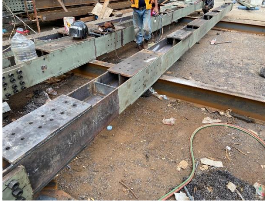
Gambar L-1.1 Kolom H-Beam 300 x 300 x 10 x 15
