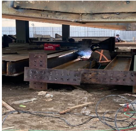
Gambar L-1.4 Balok WF 350 x 175 x 7 x 11
