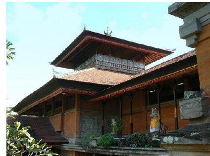
Gambar 2.28 Gedung Perpustakaan (Sumber: Buku Statistik Kepariwisataaan DIY, 2016)
